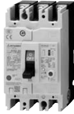
漏电断路器 [三菱电机(株)制造]
